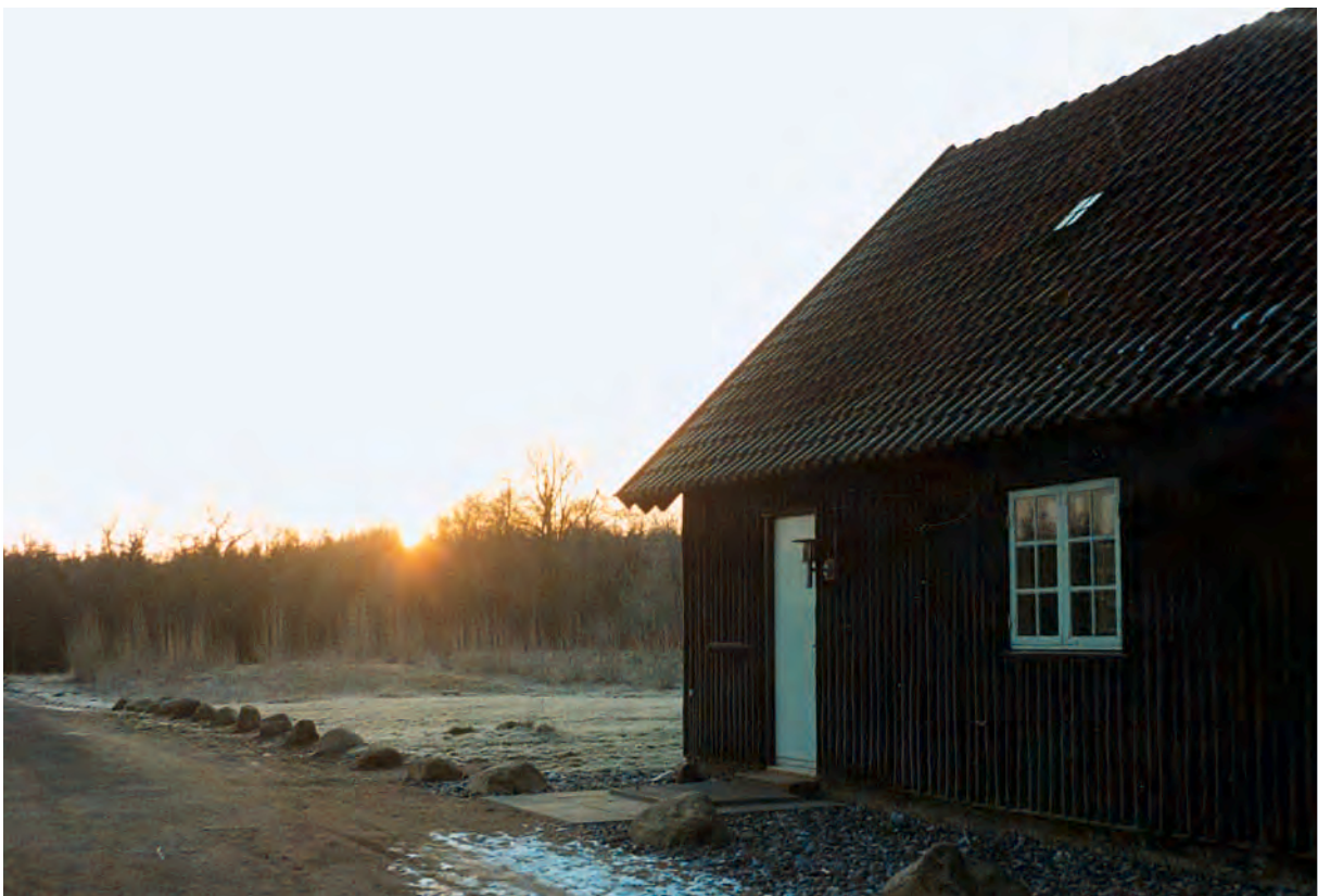
Vintersol ved Skovhuset.
