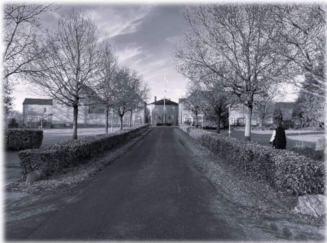
Forsorgshjemmet Saxenhøj, de oprindelige bygninger.
